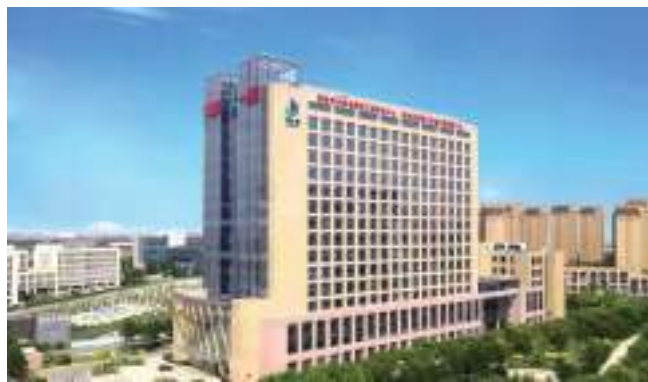
中国一重研发大楼建设项目(鲁班奖)
