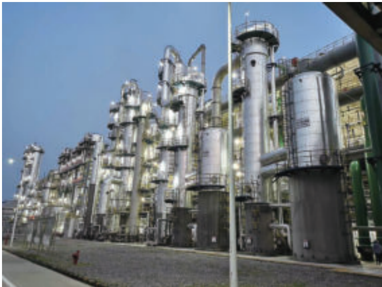
河南平煤神马聚碳材料有限责任公司40万吨年一期10万吨聚碳酸酯项目,总造价超10亿元
