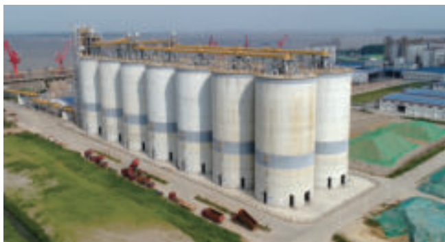
江苏润华物流有限公司上游14只内径26米、高54米筒仓群项目(扬子杯)
