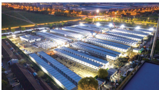
昆山周市健康驿站(防疫隔离点)一期工程
