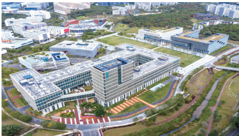
南方科技大学校园建设工程(二期)项目施工总承包I标
