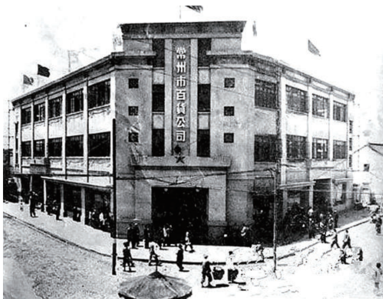
上世纪五十年代常州二建承建的常州市百货公司大楼
