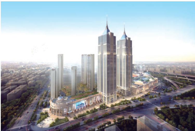
常州月星商住楼工程
