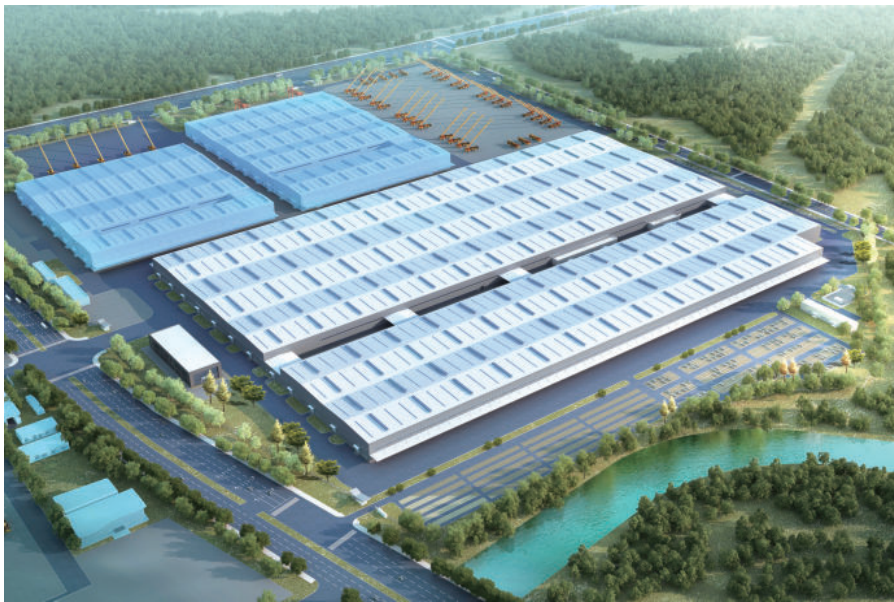
徐工高端起重装备智能工厂建设项目
